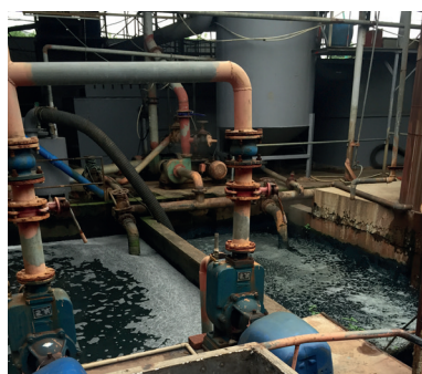
Moderne renseanlegg på denim fabrikk.
